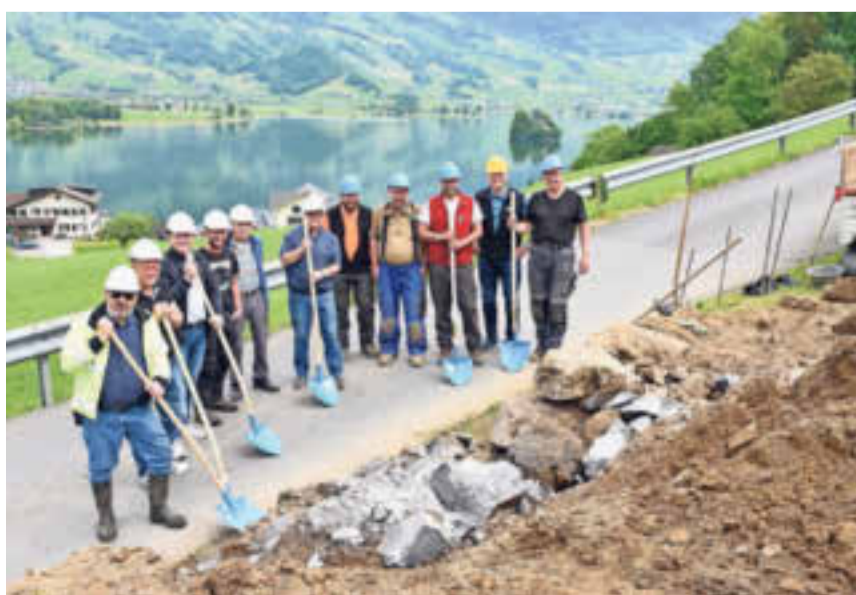
Vertreter der Gemeinde Lauerz, der Stiftung Zingel, der Abbruch + Forst AG sowie Bewirtschafter und Grundeigentümer geben mit dem Spatenstich den Start zur Sanierung der ersten Trockensteinmauer.
