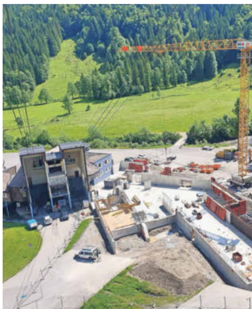
Nach etwas mehr als fünf Wochen Bauzeit nimmt die neue Talstation in der Weglosen bereits mächtig Gestalt an.
