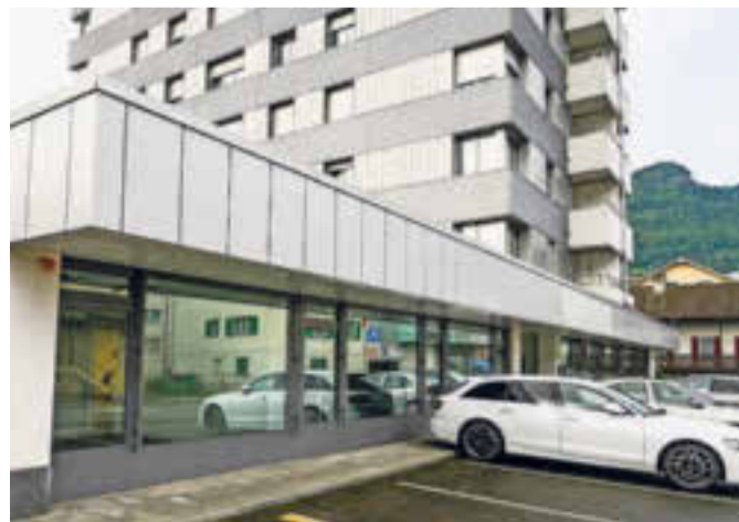
Im Erdgeschoss des ehemaligen Tierpark-Verwaltungsgebäudes wird Pro Infirmis Anfang nächsten Monat einziehen. Bild: Erhard Gick
