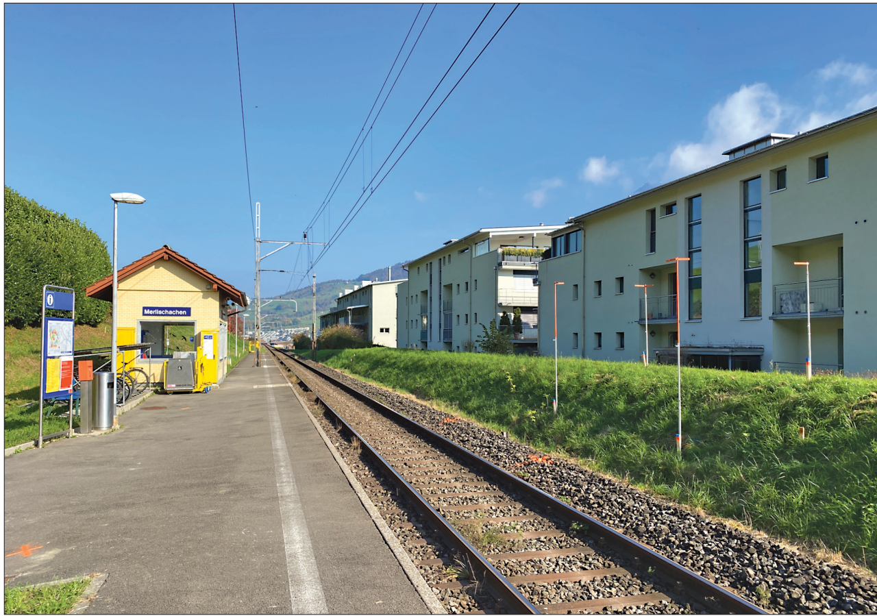
Um das Ein- und Aussteigen während der Bauzeit zu gewährleisten, wird auf der Südseite des Gleises ein provisorischer Perron mit einem gedeckten Wartebereich erstellt.
